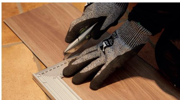
В местах, где сложно соединить планки SPC Uniclic при помощи подбивочного блока (например, у стены), можно использовать специальную скобу и молоток для соединения планок.
